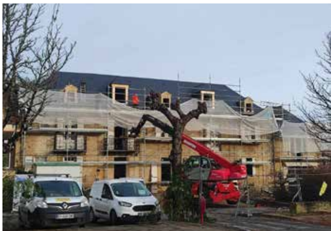
Travaux en cours
